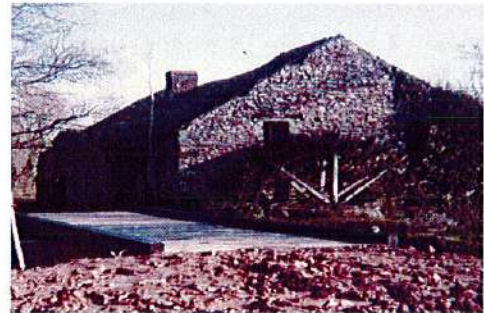
Moulin des Épinais
